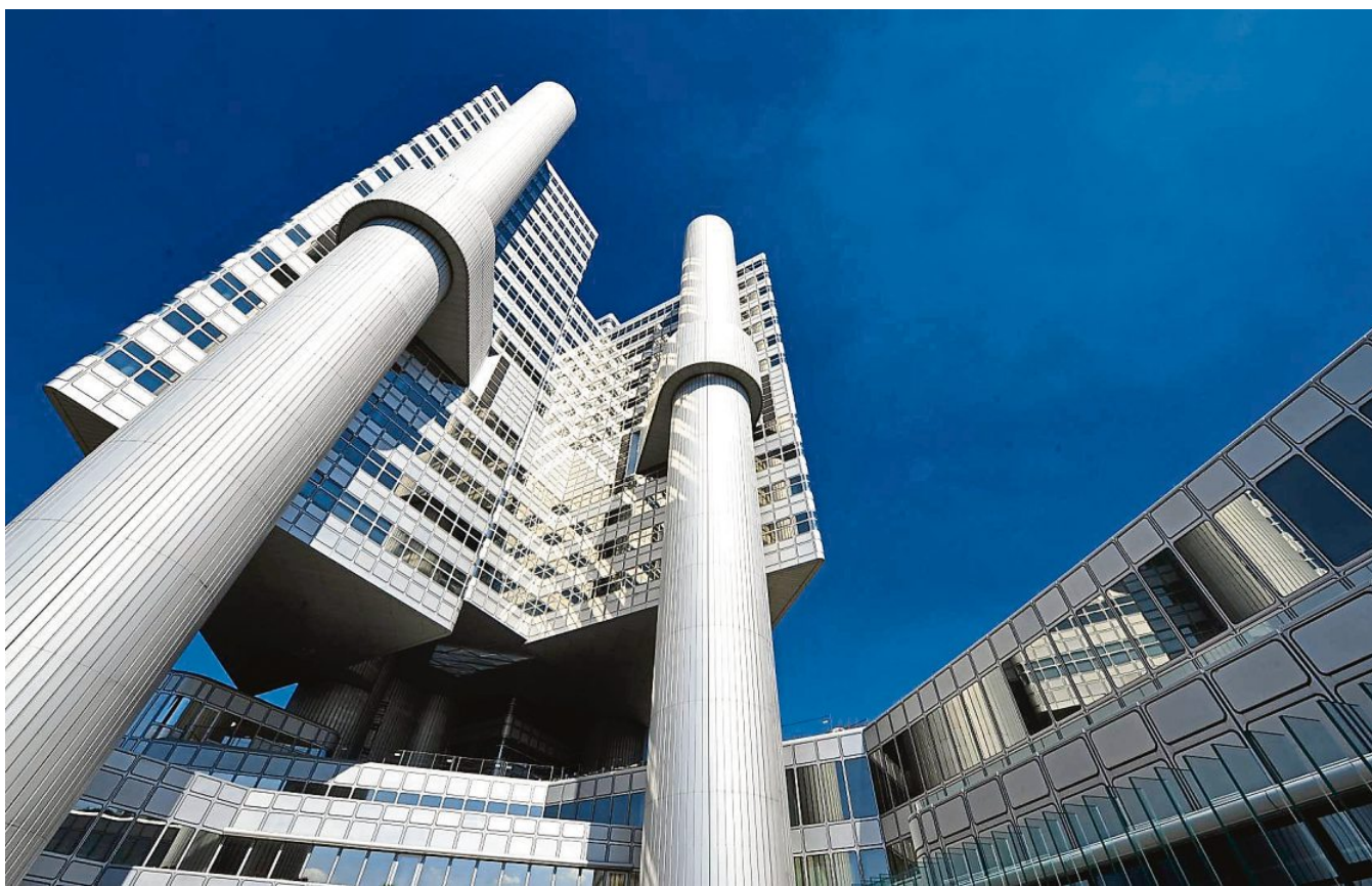
Schwebende Firmenzentrale in München: Seit 35 Jahren werden die Büros der HVB-Angestellten von vier Stützpfeilern getragen. Gewaltige Manschetten im elften Geschoss leiten die Kräfte des Hypo-Hochhauses in den Boden. FOTOS: MARCUS SCHLAF
